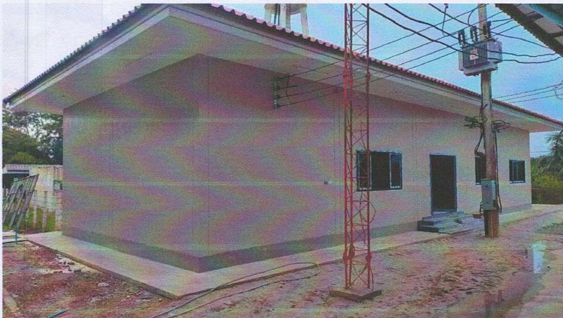
โครงการก่อสร้างอาคารห้องประชุมสภาเทศบาลตำบลดอนประดู่ ขนาดห้องประชุม 8x20 ม.
